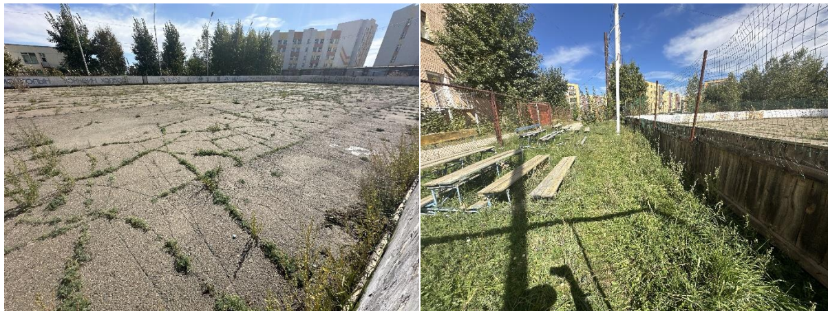
Зураг 80. Хоккейн талбайн тохижилт
